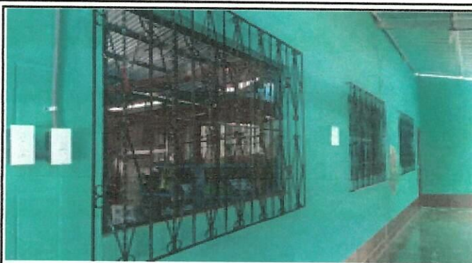
Foto 2: mejoramiento de ventanas
