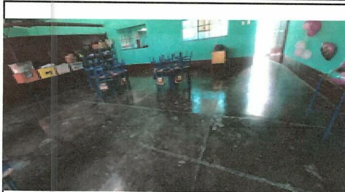
Foto1: mejoramiento de piso en aulas
