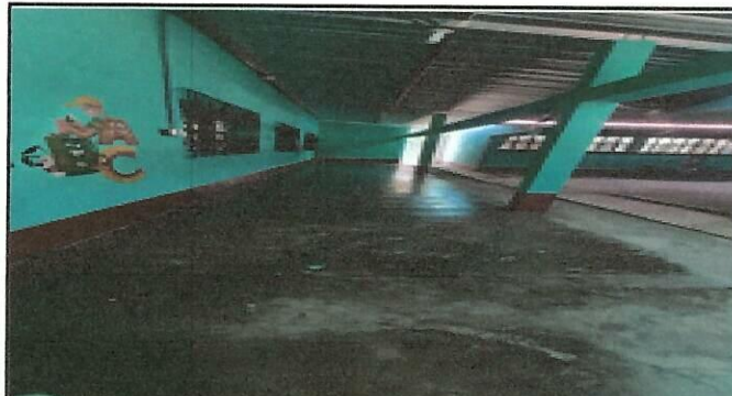
Foto 4: mejoramiento de piso de pasillo
